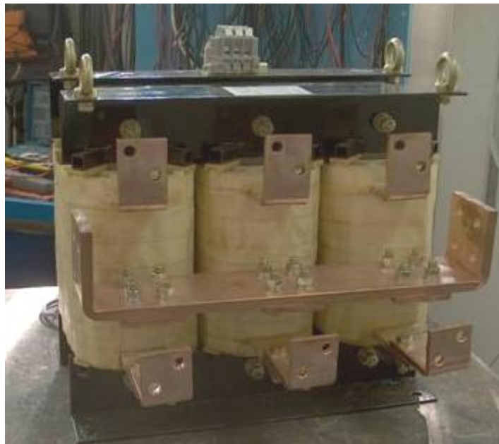
Рис 2. Трансформатор преобразовательный типа ЕТ6S мощностью ок. 60 кВА
